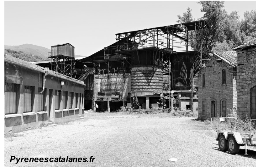
Usine de traitement du minerai de Batère à Arles sur Tech (66)
